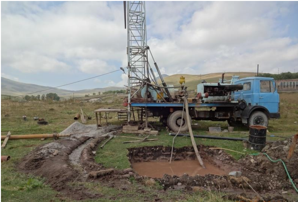
Ճամբարակ - դաշտային վերահսկողություն, խորքային հորի հորատում
